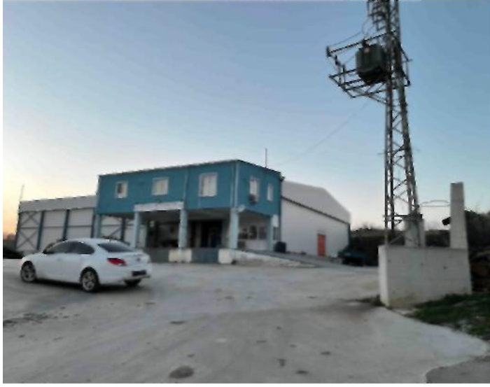
Soğuk hava deposu
